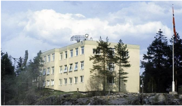
Figur 3. Radarbygget på Lutvann med radarantenne for AN/FPS-8 og AN/FPS-6A på taket. (Foto: lbsr-eu)
